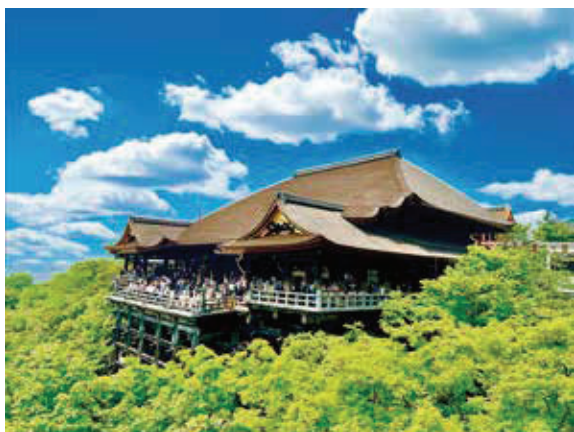
清水寺最具標誌性的建築主殿，或稱清水舞台
